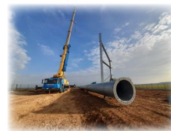
L'année 2021 a vu apparaître sur le site de la déchèterie, la première brique du projet PRÉLUDE. Au mois de mars, l'éolienne à axe vertical, développée par la Société FAIRWIND, a été installée et raccordée au réseau, après un chantier de 3 jours nécessaire à son montage.
