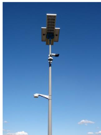
Dans la continuité du projet PRÉLUDE et de la modernisation de la déchèterie, le site a été équipé de **12 lampadaires solaires autonomes**. Ce dispositif, totalement sobre en énergie, renforce la sécurisation actuelle du site (caméras) en variant sa luminosité dès pénétration dans l'enceinte et en lançant une sirène pour décourager les visites nocturnes.
